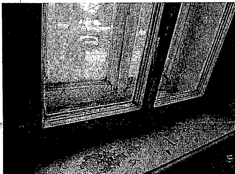
Фото 10. Фрагмент деревянного оконного заполнения с двойными рамами
