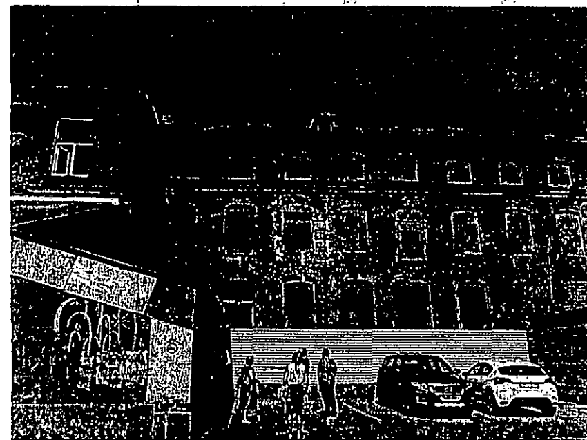
Фото 1. Вид на здание пекарни И.М. Филиппова с восточной стороны, стрелкой указан ряд оконных проемов 3-го этажа с лучковыми перемычками, третий и пятый оконные проемы с изменением исторических габаритов и конфигурации
